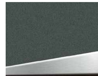
Trittschutz in Edelstahloptik, flächenbündig in die Türfüllung eingelassen
